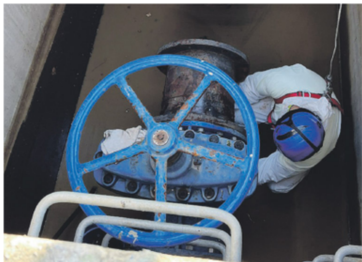
I lavori in corso sulle prese del Cer
